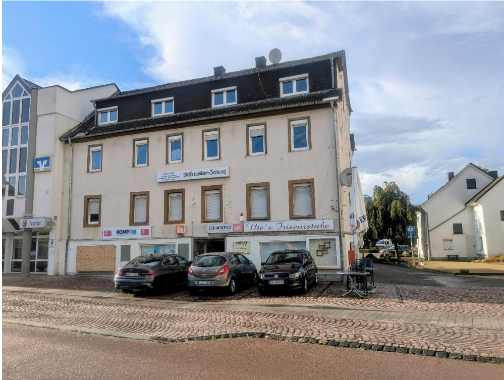
Ansicht des Bestandsgebäudes „Rheinstraße 35“ vom Marktplatz / Rheinstraße
